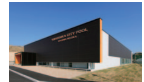
分譲地内の佐島の丘温水プール
