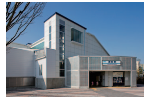
港町駅駅舎改修工事
