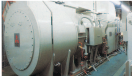
フライホイール式電車線電力蓄勢装置
