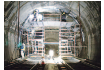
トンネルの補修工事の様子
