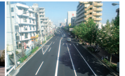
中原街道路面補修工事
