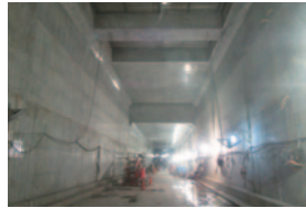
産業道路駅付近での躯体構築状況
